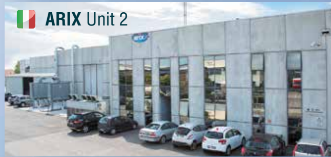
ARIX Unit 2 Produzione Scope e Strumenti - Brooms & Tools Manufacturing Total Area: 10.000 mq - Buildings: 8.000 mq
